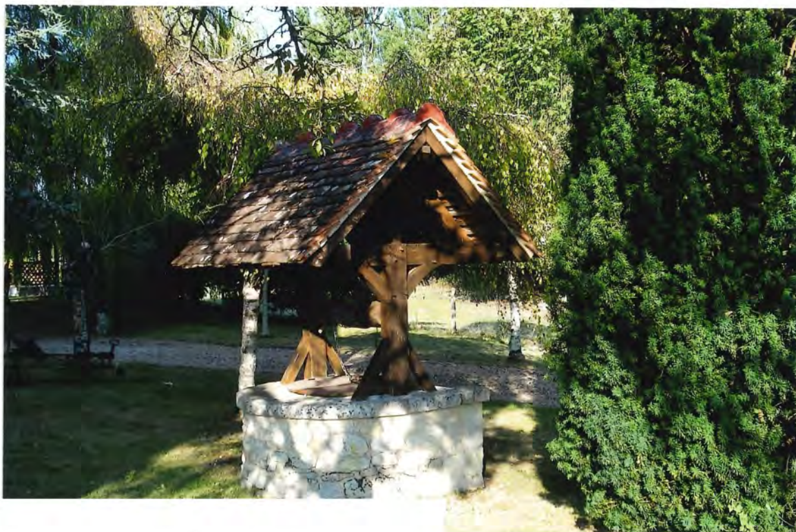
Puits à margelle circulaire. Des montants en bois supportent Le treuil et le toit
