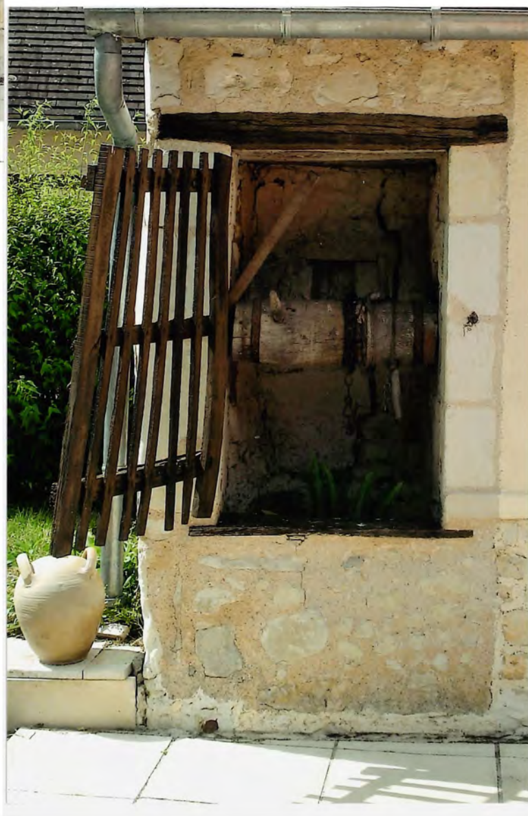
Ce puits jouxte la maison d'habitation
