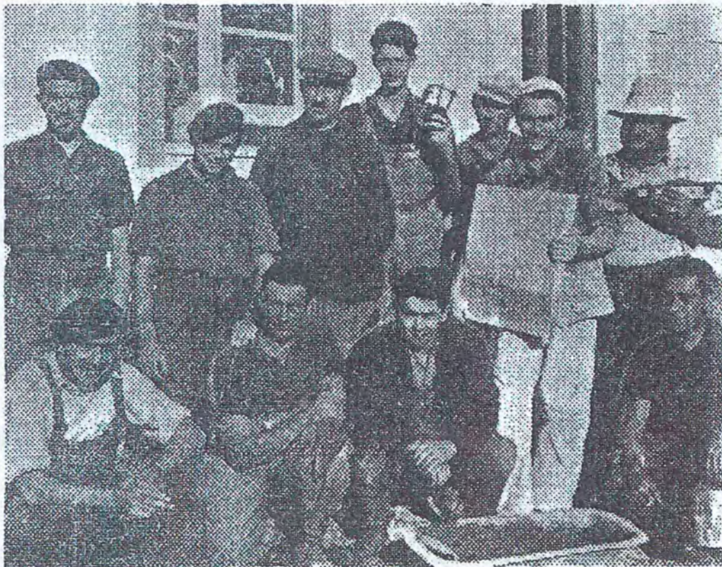
Les ouvriers qui terminent les travaux pour les logements des instituteurs.
